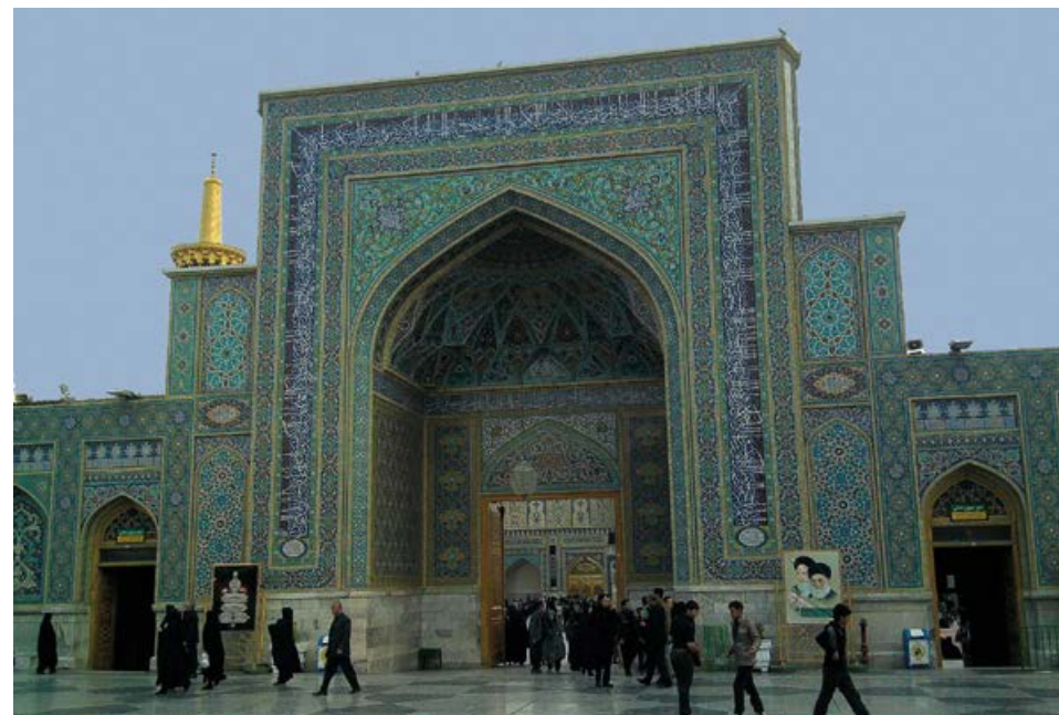
● Ściany pokrywają wzory z fajansowych płytek
